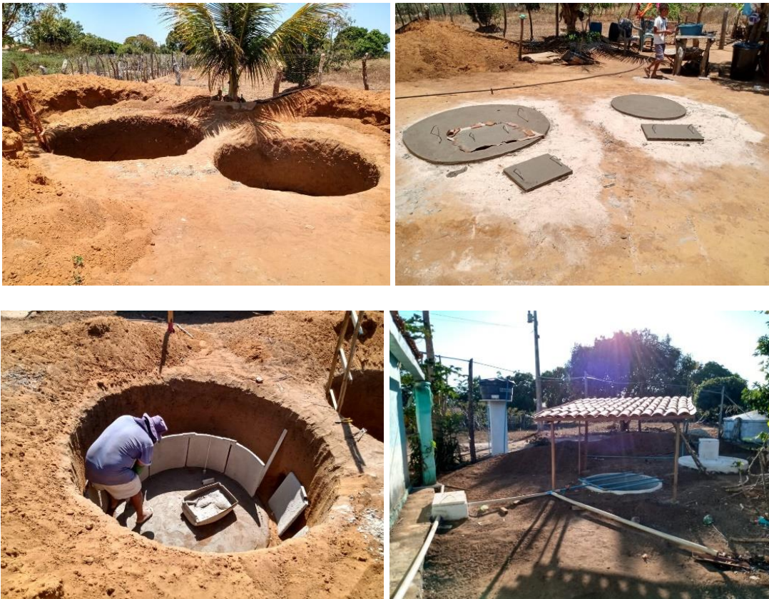
Fotos 08,09, 10 e 11: Construção da parte de alvenaria e sistema de biágua pronto. 3
