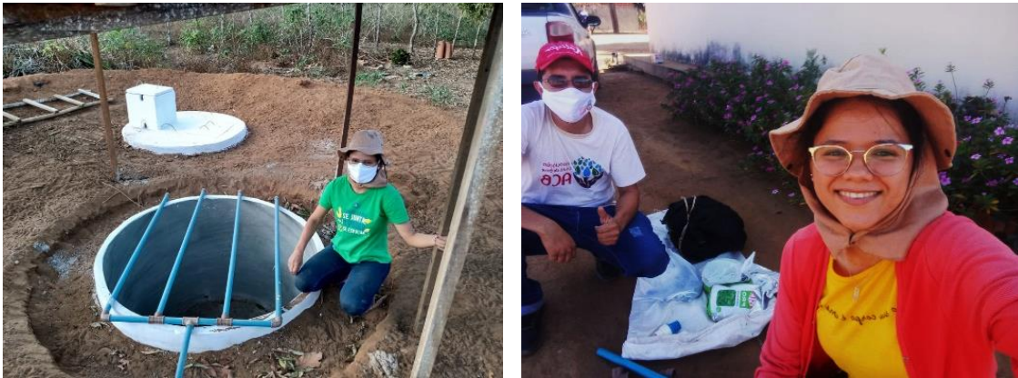
Fotos 27 e 28: Parte da instalação do filtro biológico montado e da participação do técnico Evandro Santos.
