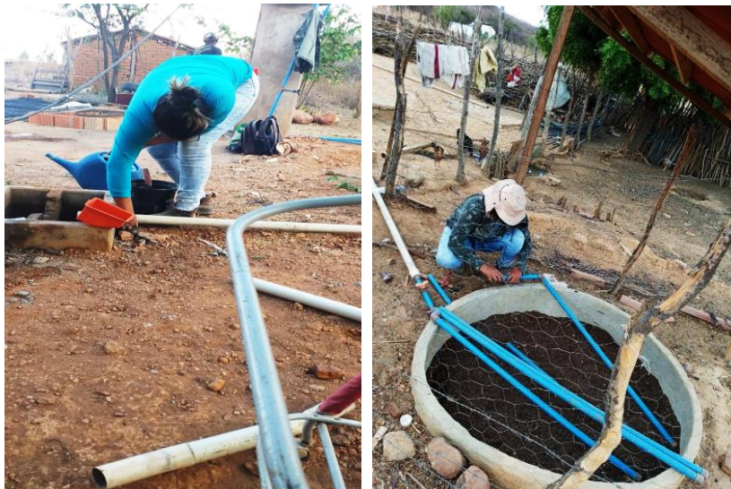
Fotos 21 e 22: As fotos foram tiradas pelas participantes que mantiveram distância da técnica que explicava a montagem e manutenção dos itens do filtro biológico e caixa de gordura.
